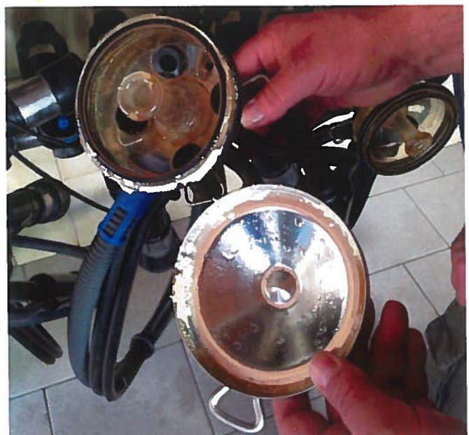
Abb. 3: Ablagerungen in einem Sammelstück
